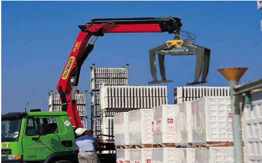
Conduite à poste fixe
